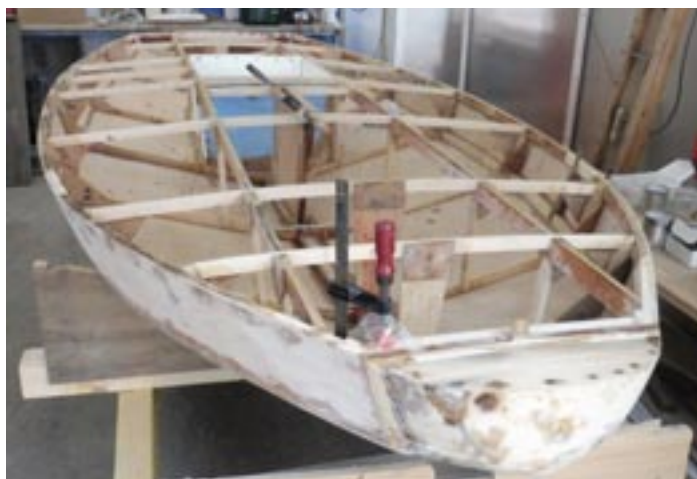
La structure enfin restaurée après des heures de travail (PhotoJR)
